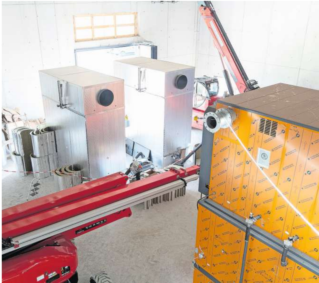
Die Holzschnitzel werden in den orangefarbenen Heizkesseln verbrannt.
