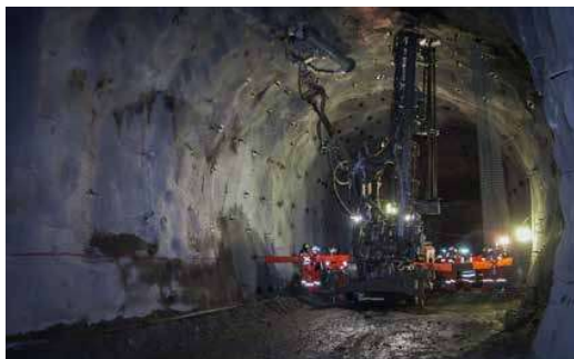
GeobruGG-Schutznetzsysteme vermindern den Einsatz von Spritzbeton im Untertagebau massgeblich und reduzieren so den CO 2 -Footprint.
