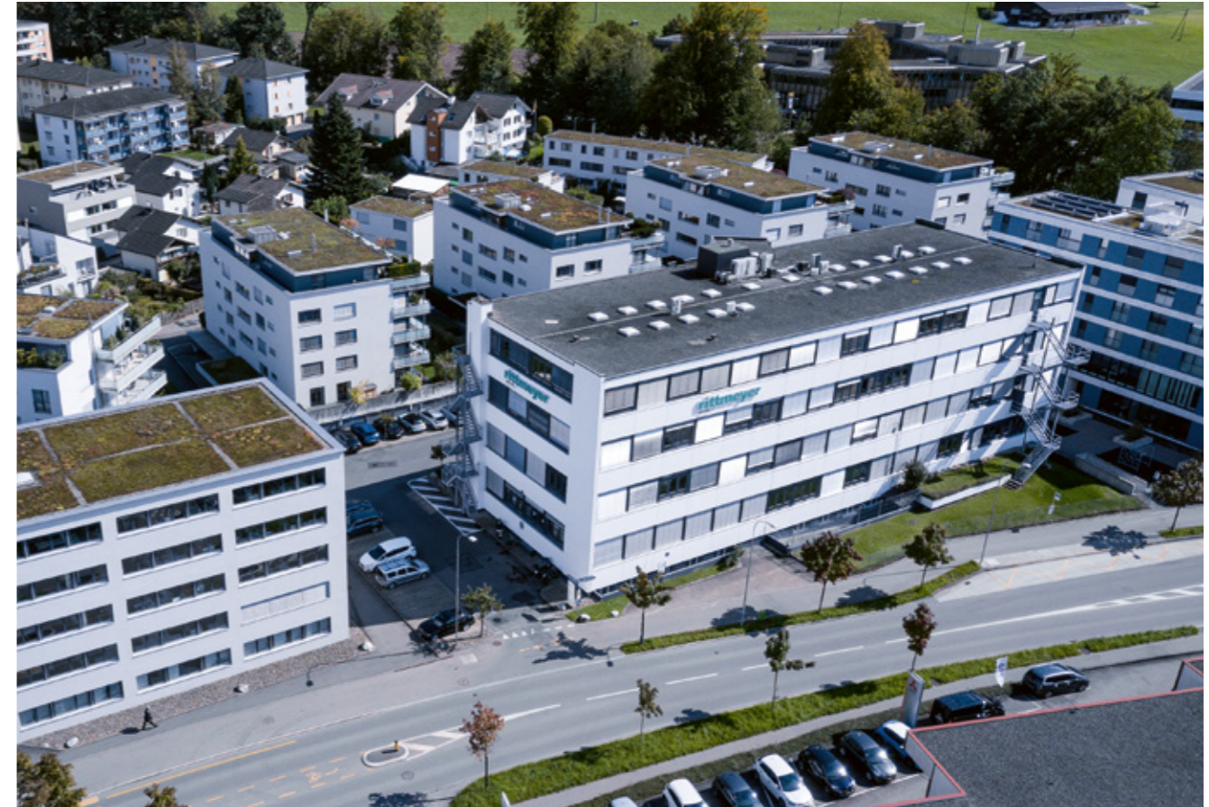
Standort Baar, Schweiz: Das fünfstöckige Fabrikgebäude ist der Hauptsitz der Rittmeyer AG. Die Räumlichkeiten sind über eine befahrbare Rampe, ein Treppenhaus, einen Personen- und einen Warenlift erschlossen.
